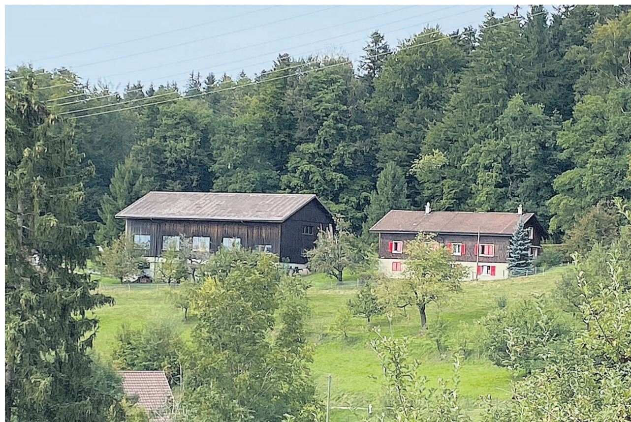
Diese nach Süd-Westen ausgerichteten Dächer im Weiler Lätte, der sich im Grenzgebiet zwischen Triengen und Dagmersellen befindet, sollen für den Zusammenschluss zum Eigenverbrauch mit Photovoltaikanlagen bestückt werden.
